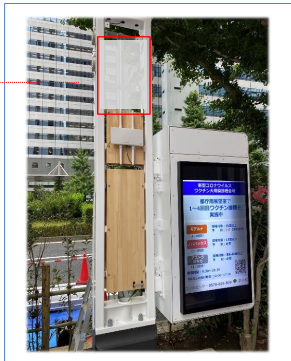
スマートポール内部構造
