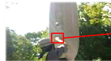
センサー固定ネジの確認
