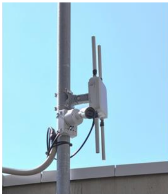
ポールに設置済のWi-Fiとカメラ
