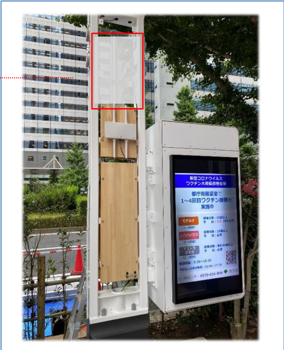
スマートポール内部構造
