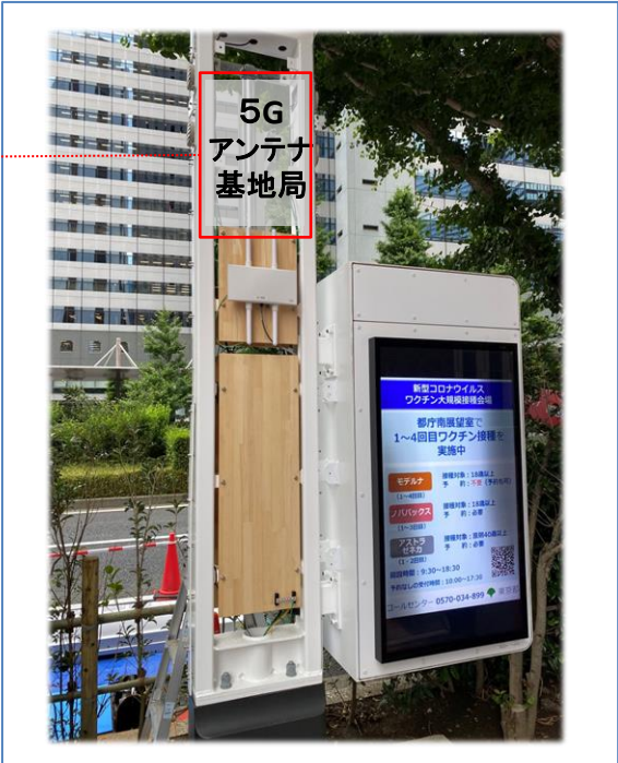
スマートポール内部構造
