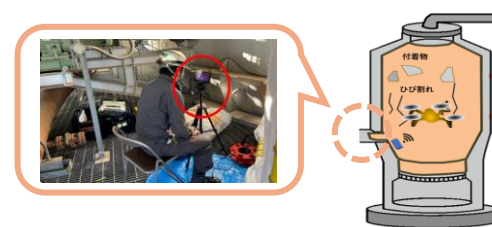
▲焼却炉の外からドローンを遠隔操作
