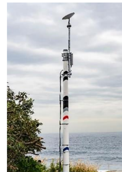
衛星通信を活用した基地局
