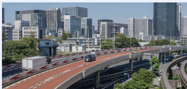
緊急輸送道路での 通行訓練(通行手続き等)
