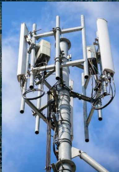
共有アンテナ設置
